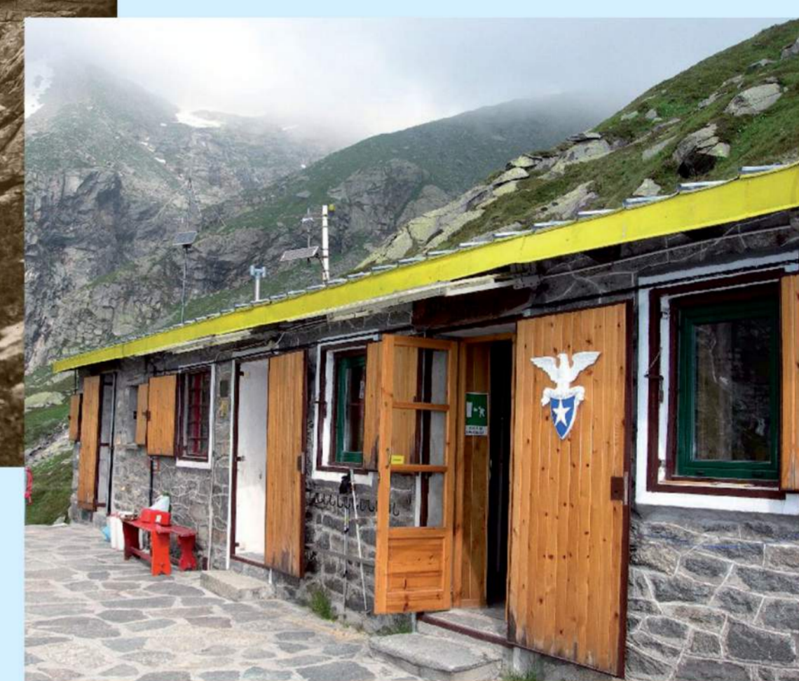
Rifugio Paolo Daviso. Archivio rifugio Daviso.
